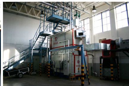
Obrázek 13.66 Pohled do kotelny s instalovaným kotlem typu KOLBACH 1,6 MW.
