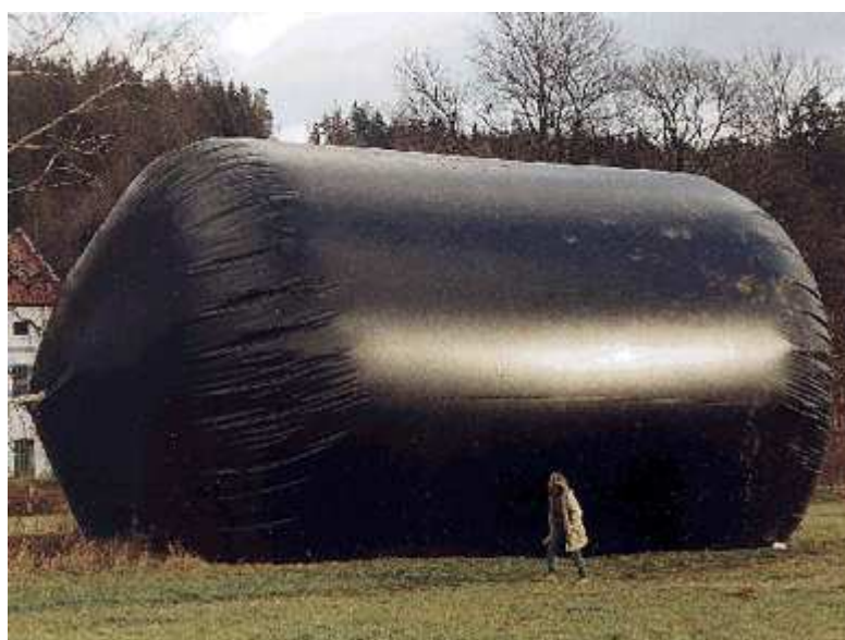
Obrázek 9.17 Nízkotlaký plynojem typu VAKBIG
