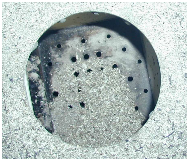
Obrázek 4.1 Pevný rošt kotle o výkonu 35 kW
