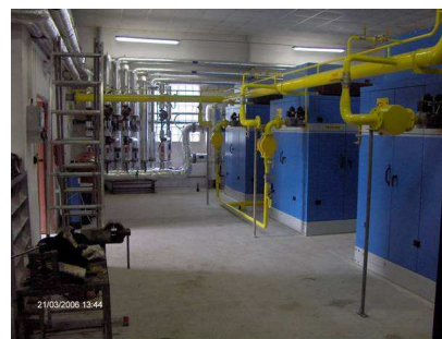
Obrázek 13.28 Pohled na objekt Obrázek 13.29 Kogenerační jednotky
