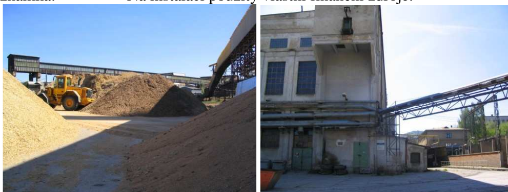
Obrázek 13.121 Sklad paliva, část vytápěných objektů
