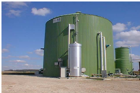
Obrázek 9.7 Vertikální konstrukční typ fermentoru
