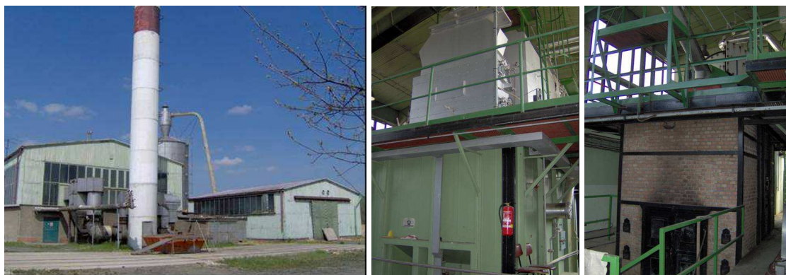
Obrázek 13.12 Pohled na objekt Závodu lesní techniky (levá část je kotelna, pravá část je přilehlý sklad)
