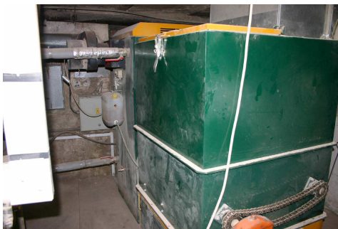
Obrázek 13.90 Kotel na dřevní odpad je umístěn v suterénu komplexu budov.
