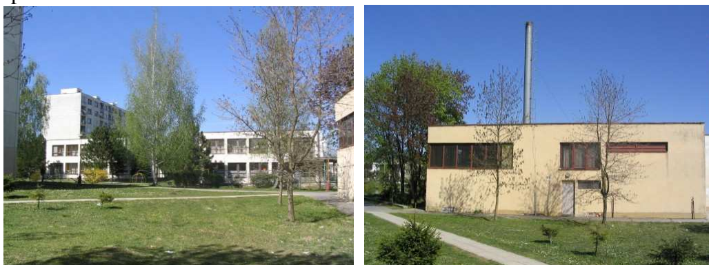
Obrázek 13.130 Vytápěné objekty, kotelna
