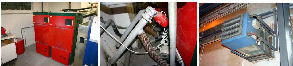
Obrázek 13.110 Kotelna s dvojicí kotlů o výkonu 50 kW zároveň slouží k testování spalování jednotlivých druhů pelet.
