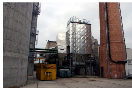
Obrázek 13.63 Pohled na venkovní technologii kotelny - zásobníky paliva.
