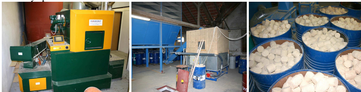
Obrázek 13.80 Kotel na spalování dřevního odpadu z výroby.
