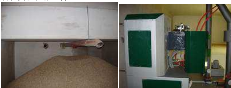
Obrázek 13.124 Zásobník paliva, kotel
