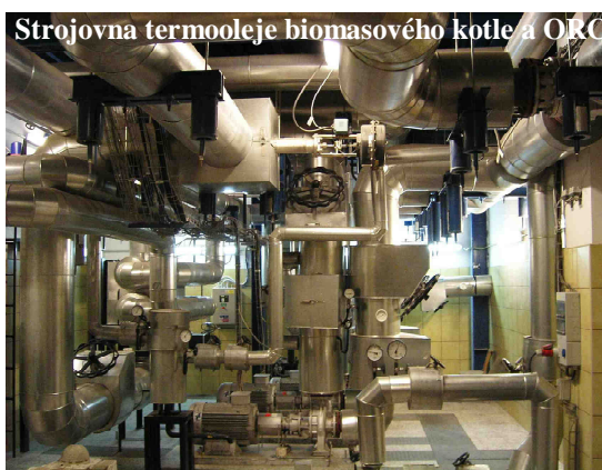
Regenerátor a čerpadlo silikonového oleje
