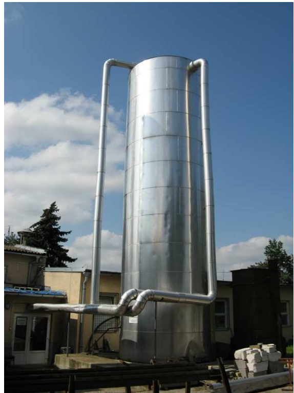
Obrázek 42 Venkovní akumulční zásobník teplé vody o celkovém objemu 800 m 3
