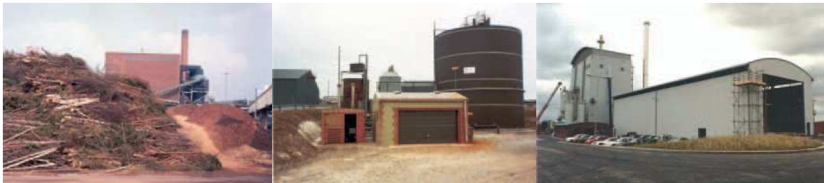
Obrázek 1 Výtopna na biomasu [1]
