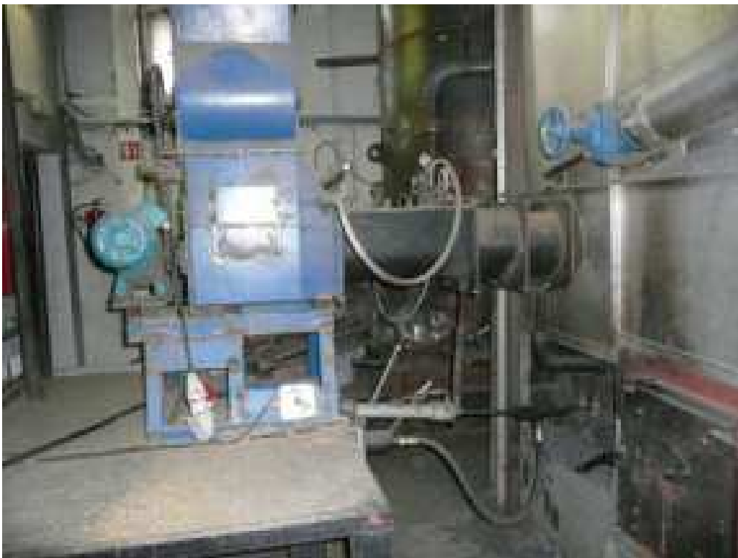
Obrázek 38 Turniket a podávací šnek slámy do kotle
