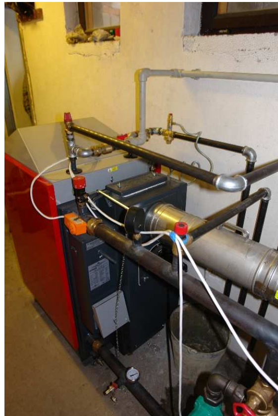
Obrázek 30 Ukázky instalací plynových kotlů Atmos v domácnostech
