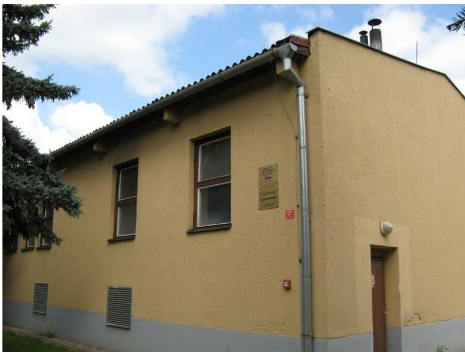
Obrázek 33 Objekt centrální kotelny na biomasu v obci Velký Karlov
