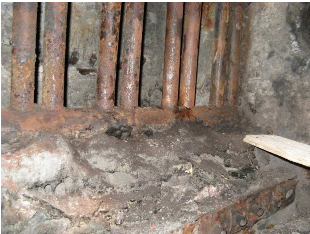
Obrázek 39 Teplosměnná plocha na konci ohniště
