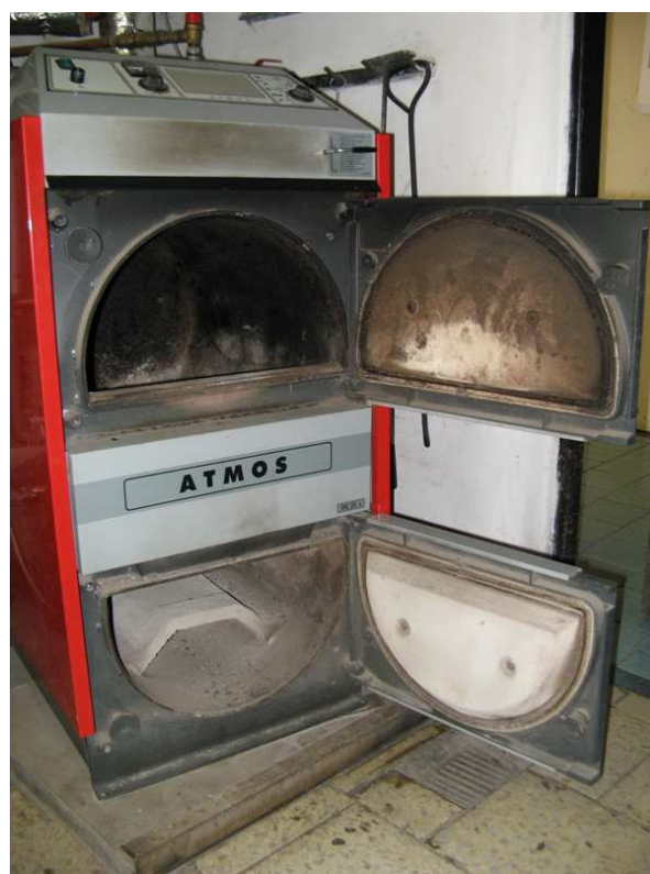
Obrázek 27 Ohniště zplyňovacího kotle Atmos
