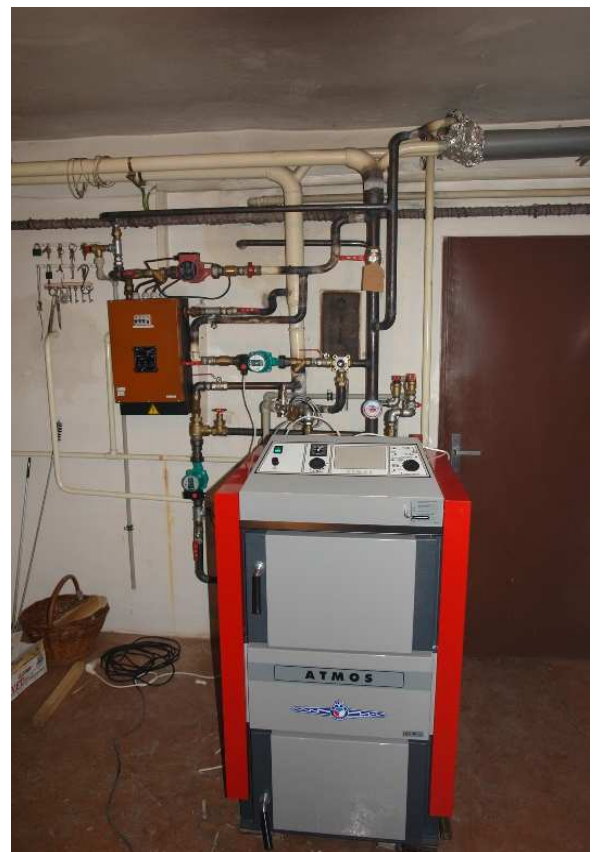
Obrázek 29 Kotelna po instalaci zplyňovacího kotle
