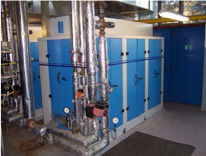
Obrázek 5 Kogenerační jednotka Tedom MT 140 SP
