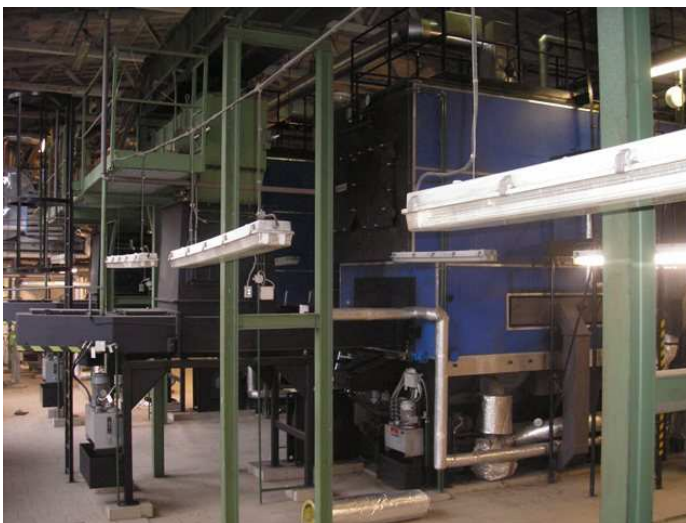
Obrázek 9 Kotel Danstoker DHF 8
