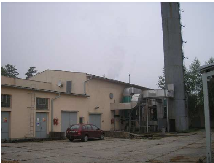
Obrázek 8 Kotelna ve městě Zlaté Hory
