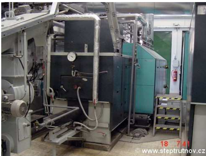
Obrázek 1 Kotel na dřevní štěpku Verner
