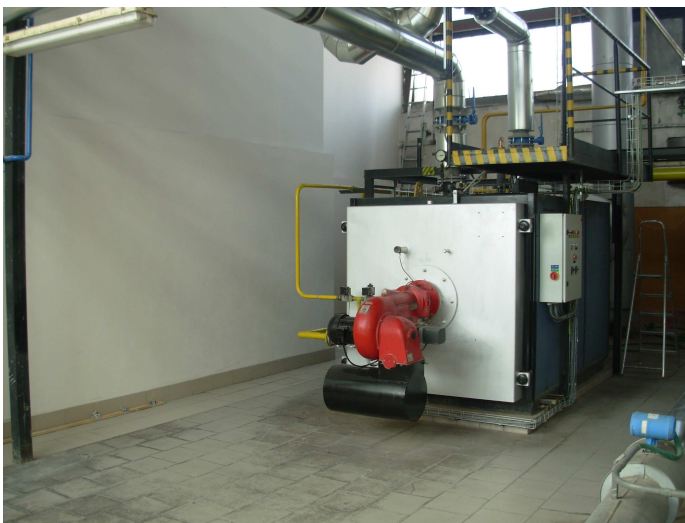
Obrázek 2 Kotel na dřevní štěpku HRK 1000
