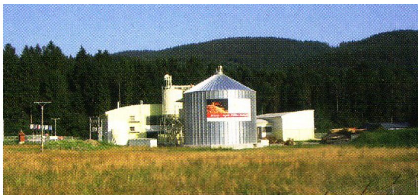
Obr. č. 46 Celkový pohled na CPU v Kysuckom Lieskovci
