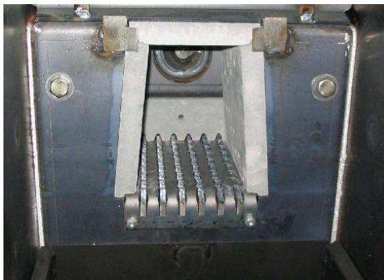
Obr. 2 Spalovací komora kotle Verner A25
