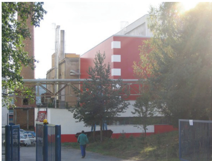
Obrázek 6.1 Pohled na areál společnosti Hriňovská energetická, s. r. o.
