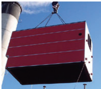
Obrázek 6.6 Instalace kotle BK1
