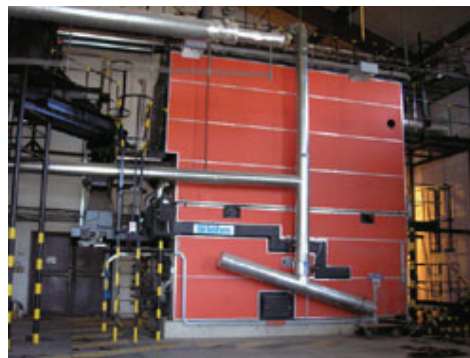
Obrázek 6.7 Kotel BK1 po instalaci
